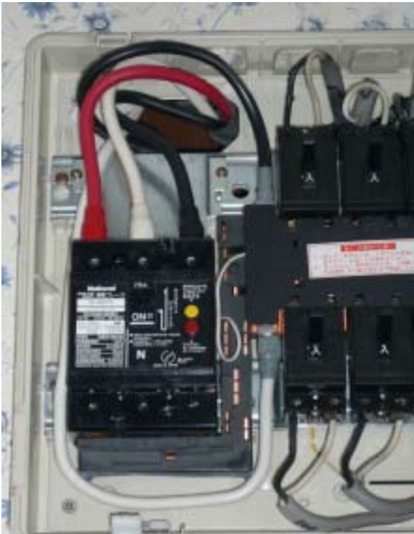
設置可能な分電盤(例)
