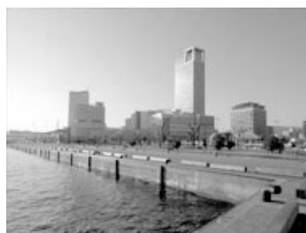
サンポート高松地区地域冷暖房施設
