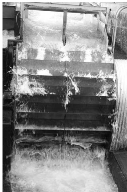
マイクロ水力発電(山梨県都留市)
