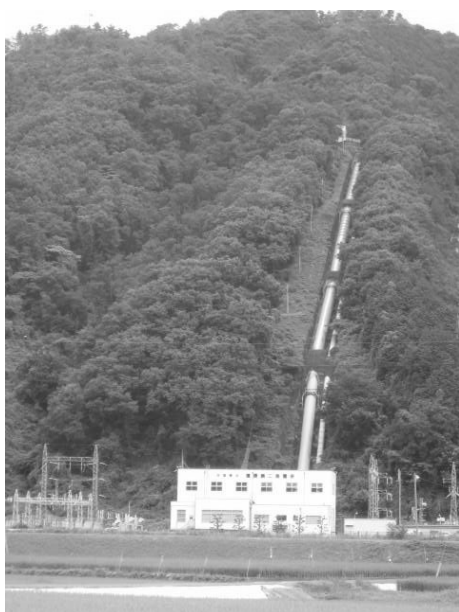
小水力発電(岡山県真庭市)
