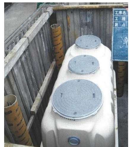
浄化槽設置の様子
