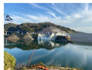
常時満水位の安威川ダム
