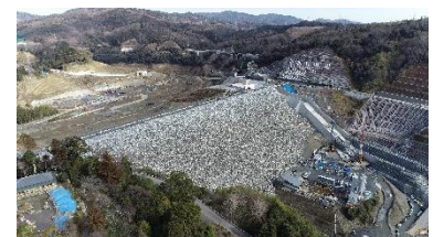
堤体工事が完了した安威川ダム (令和4年1月)
