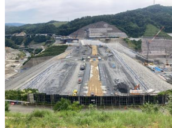
工事中の安威川ダム (令和3年8月)
