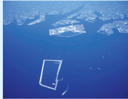
大阪湾埋め立て処分場
