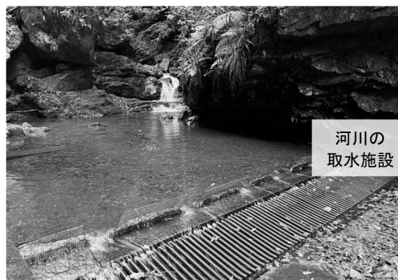
小水力発電 取水施設
