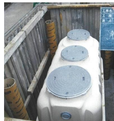
浄化槽設置の様子
