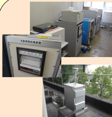
市役所観測室の様子
