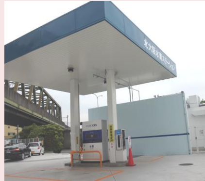
北大阪水素ステーション
