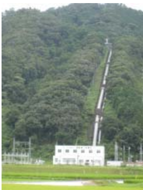
小水力発電(岡山県真庭市)
