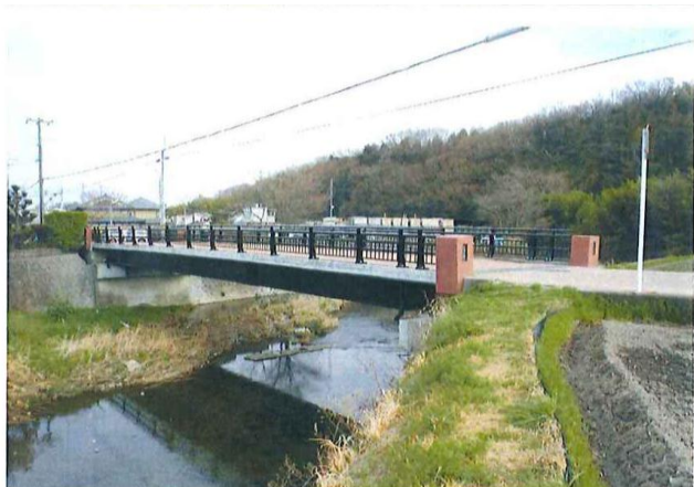
改修後の橋梁（山下橋）
