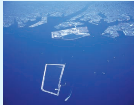
大阪湾埋め立て処分場
