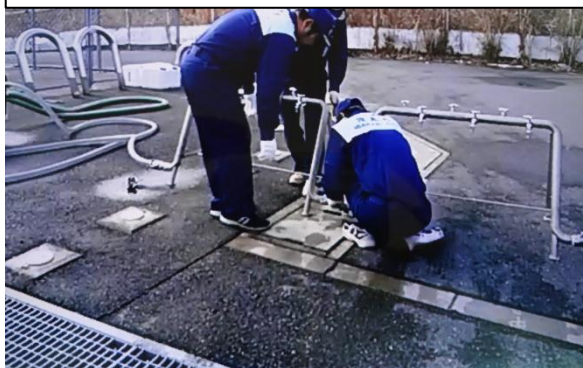
給水装置器具を設置する様子
