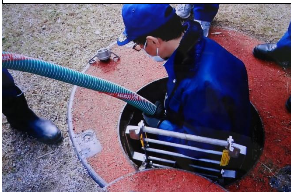
水を汲み出すポンプを接続している様子
