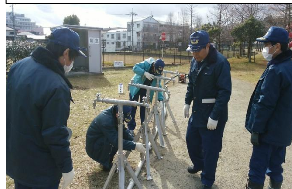
給水装置器具を設置する様子
