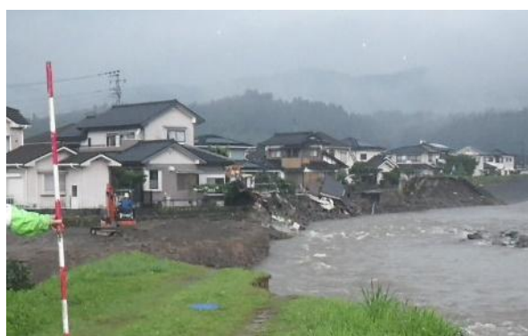
河岸侵食による家屋の倒壊(花月川)
