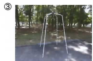
③ 骨組み完成。
