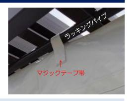
① 脚立を利用して「ラッキングパイプ部」にテント上部のマジックテープ帯を巻き付けます。
