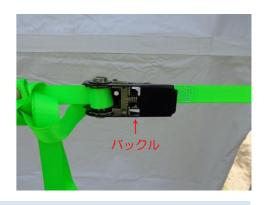
② 「テント取付補強帯」を柱の内側から回し、フックを取付け、荷締めベルト(緑色ベルト)でしっかりと引張り、バックルで固定します。
