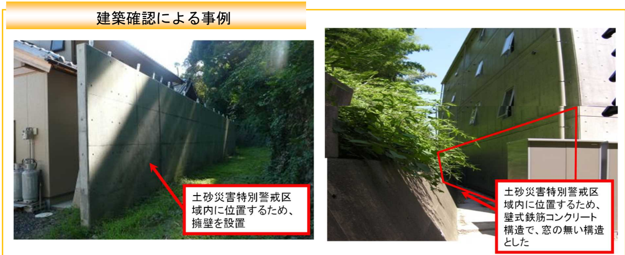
図 16 建築確認による事例
