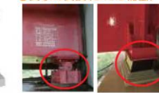
交換前（鋼製支承） 交換後（免振ゴム支承）
