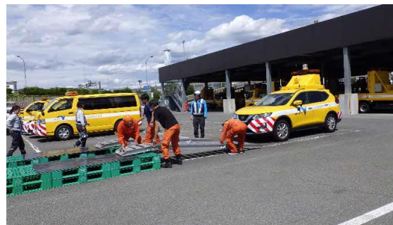
← 段差修正実働訓練の様子
