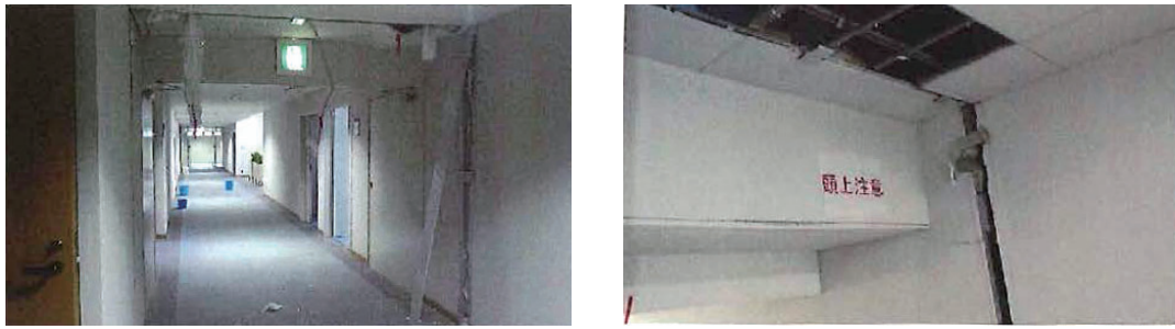
図表 市役所本庁舎内の被害（左：本館5階廊下、右：本館7階廊下）
