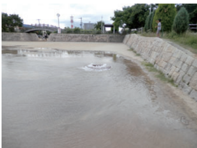
図表 市内の公園施設の状況 (桑田公園では配水管附属設備（空気弁）が損傷し、水が溢れた)
