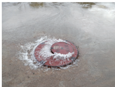
図表 市内の公園施設の状況 (桑田公園では配水管附属設備（空気弁）が損傷し、水が溢れた)
