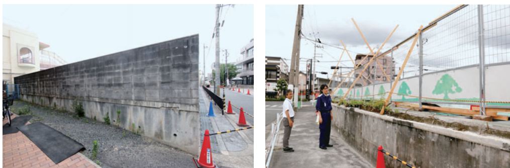
図表 学校ブロック塀の点検・撤去
