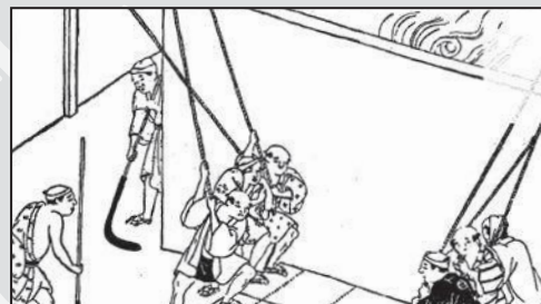
たたら製鉄における踏み鞆による送風作業
