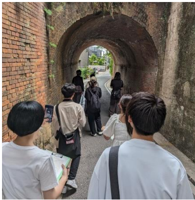
上泉町と田中町を結ぶレンガ造りの トンネル丸またに興味深々！
