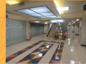
駅前ビルの老朽化・内向き店舗
