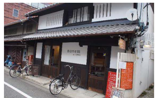
屋外広告物の規模を小さくし、落ち着いた佇まいを損なわないようにしている事例
