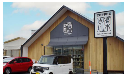
建物と一体的に計画することで、建物の外観がまとまって見えるようにしている事例
