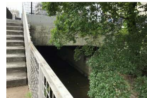
水路を覆う構造物
