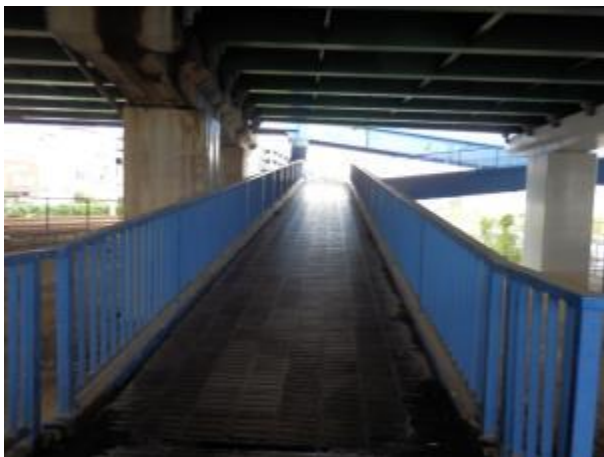
⑦ 下穂積第2歩道橋
