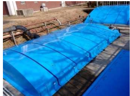
対策一例 覆蓋の設置（十日市浄水場）
