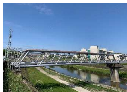
十日市水管橋
