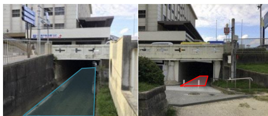
写真：南グラウンド側からみた水路及び里道
