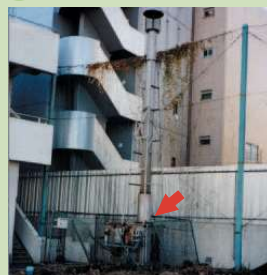
廃棄物焼却炉
