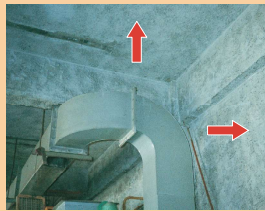
吸音用吹付け石綿・石綿含有吹付けロックウール（天井・壁等）
