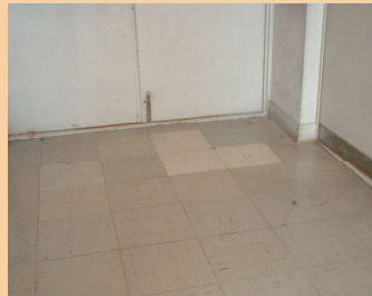
石綿含有ビニール床タイル（床）
