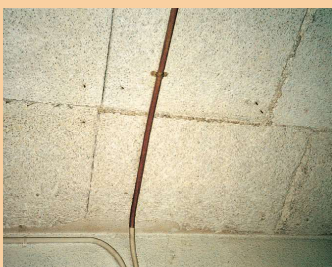
木毛セメント板（打ち込み）
