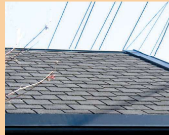
石綿含有住宅化粧用スレート（屋根）
