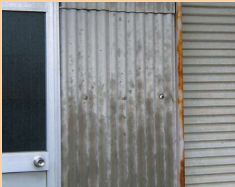
石綿スレート（屋根・外壁）
