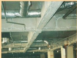
耐火被覆用石綿含有ケイ酸カルシウム板(2種)(S造の柱・梁)
