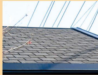
石綿含有住宅化粧用スレート(屋根)
