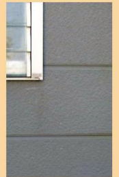
石綿板(窯業系サイディング)
