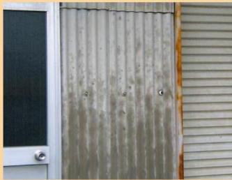
石綿スレート(屋根・外壁)
