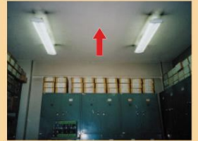
結露防止用の石綿含有パーミキュライト吹付け・パーライト吹付け(天井・壁等)
