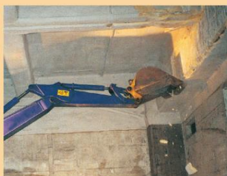
発泡ウレタン断熱材(吹きつけ)
