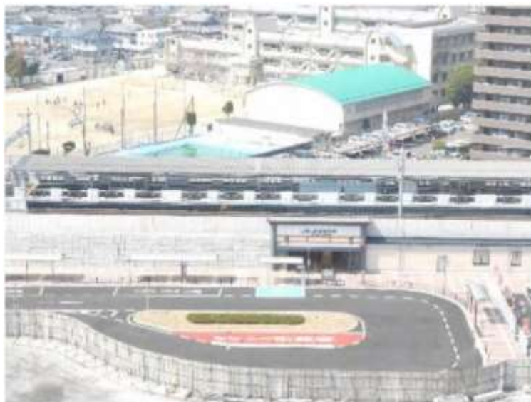
図 2.1.9 駅周辺 現況写真 出典：茨木市ホームページ
