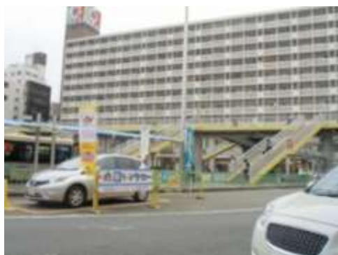
バスターミナルへの移動手段が階段しかなく不便（JR 茨木駅西口）
