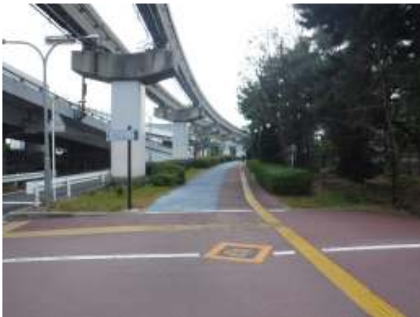
① 大阪中央環状線（1）
