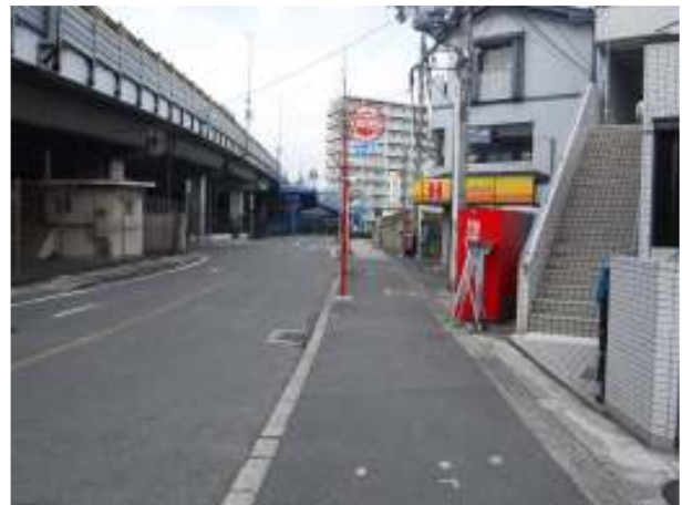
② 大阪中央環状線（2）
