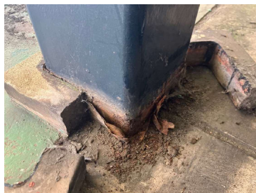
図：施設の状況
