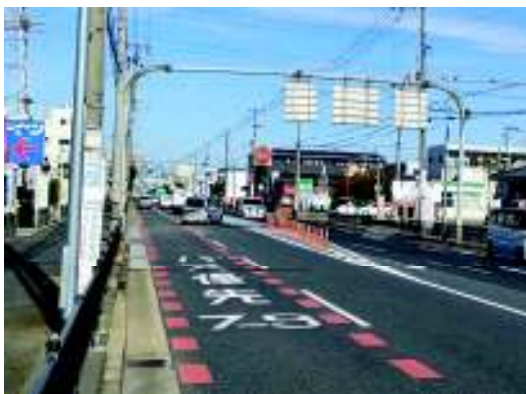
写真 バス優先レーンの設置事例
