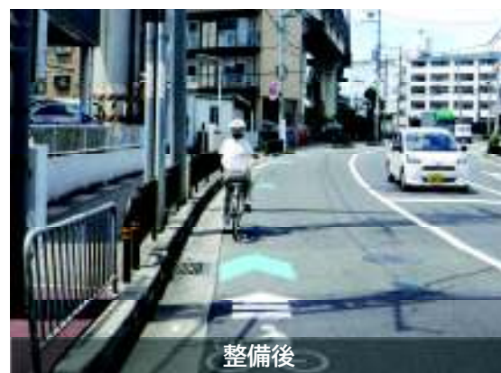
自転車レーン整備
