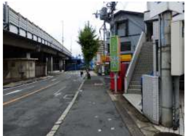
② 大阪中央環状線（2）
