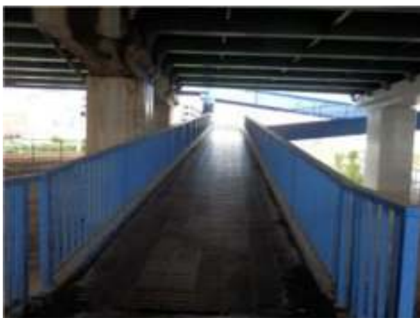
⑦ 下穂積第2歩道橋
