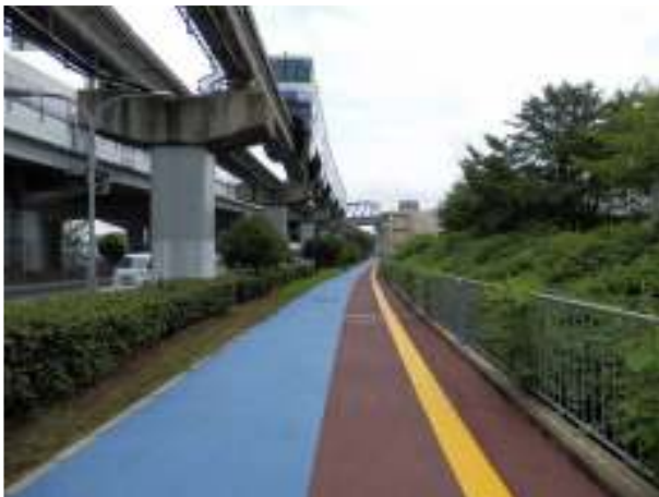
① 大阪中央環状線（1）
