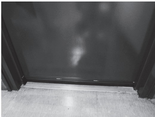
写真1 2階非常口扉 ドア隙間対策用ブラシ設置
