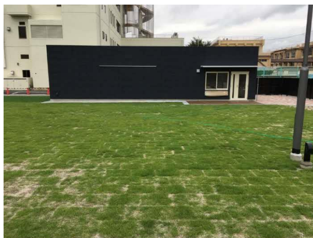
防災倉庫前面
