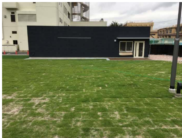
防災倉庫前面
