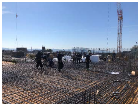
4階の床の鉄筋を組み立てています。
