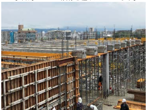
14mのコンクリート梁（約13t）を据え付けています。
