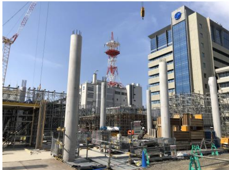
1階北側の大屋根広場の柱が建ちました。
