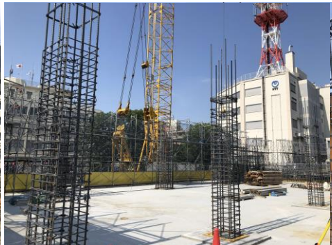
2階の柱や壁を作り始めました。
