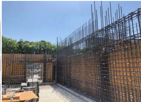
1階の柱や壁を作り始めました。
