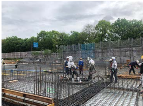
1階床コンクリートを打設しています。
