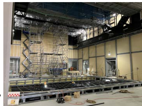
多目的ホールの昇降床の据え付けしています。
