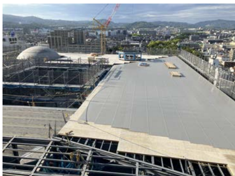
最上階では屋根の防水をしています。
