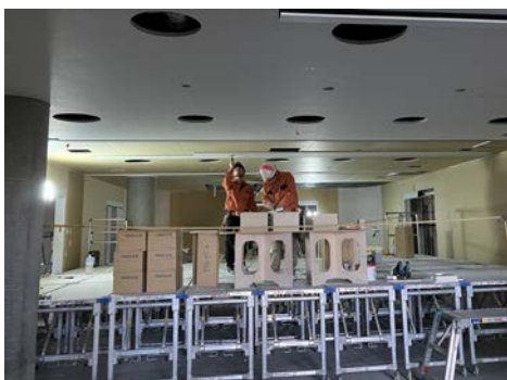
各部屋の天井ボードを貼っています。
