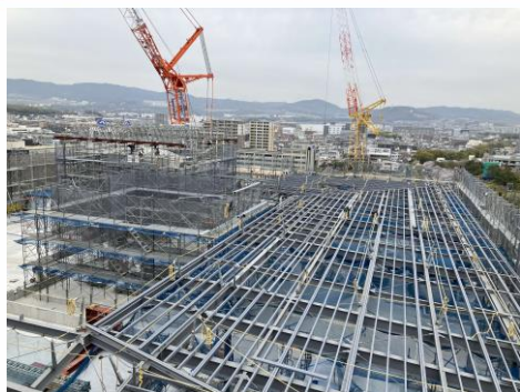
最上階では屋根の鉄骨がかかりました。
