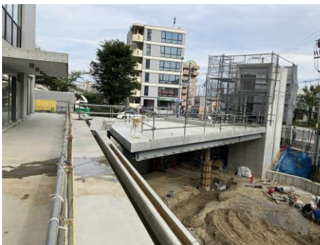
南側の交差点とM2階のデッキが繋がりました！
