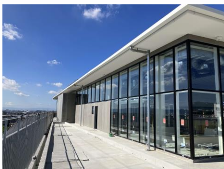
7階バルコニー 外装完了 床仕上工事へ
