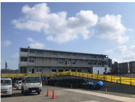
工事事務所を設置しました。
