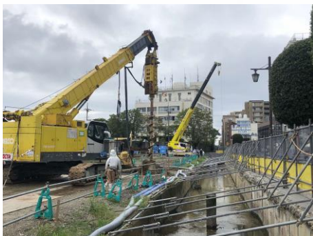
山留用の板を設置する穴を掘りました。
