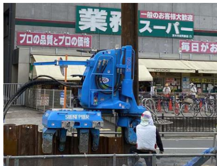
水路に沿って山留板を設置しています。
