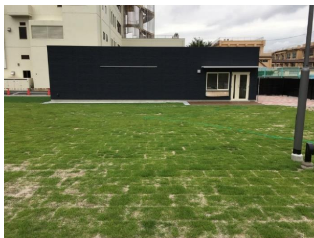
防災倉庫前面
