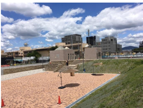
インターロッキング広場（養精中学校方面を臨む）
