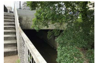
水路を覆う構造物
