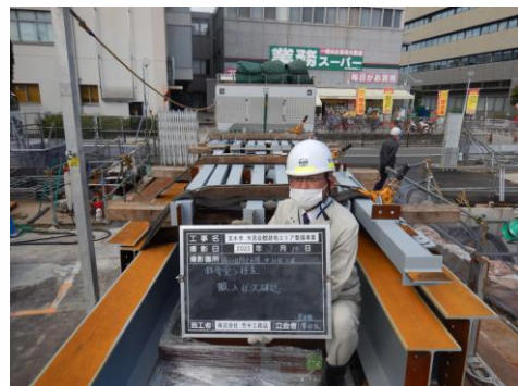
工場で製作した鉄骨を受入確認をします。
