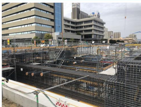
1階床の鉄筋を組立しています。
