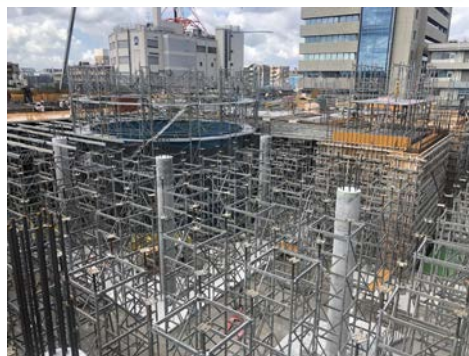
丸柱を建て、床を作るための足場を組みます。
